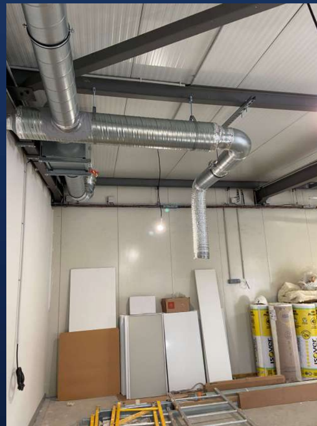
TRAVAUX Extraction et ventilation
