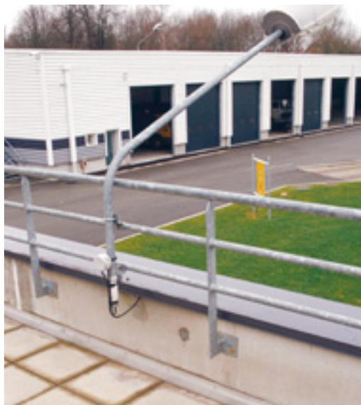
Photo 5.2. Luminaire pivotant pour le remplacement d'ampoule.
