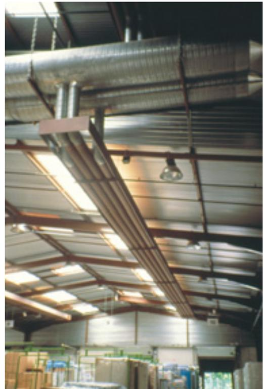
Photo 5.3. Chauffage des locaux réalisé à partir de canalisations d'air chaud agissant par rayonnement.
