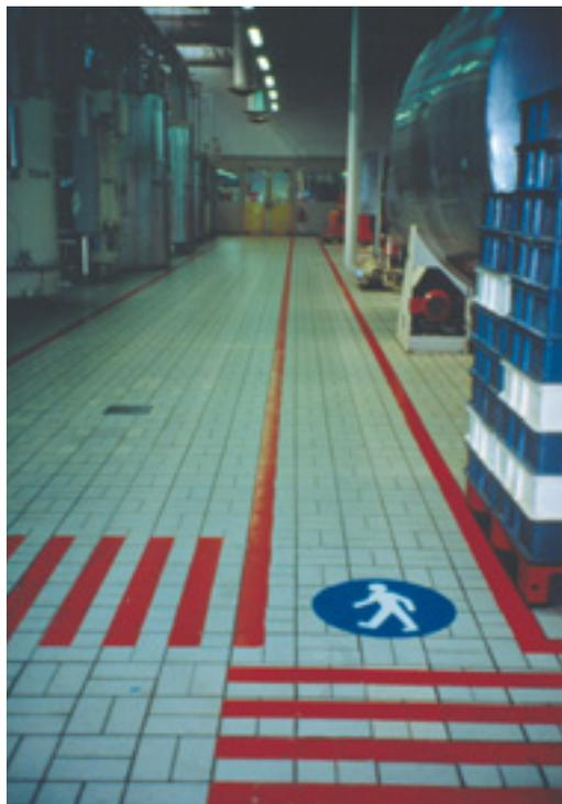
Photo 7.6. Allées de circulation intérieure, balisées et identifiées ; les sols carrelés facilitent l'entretien.
