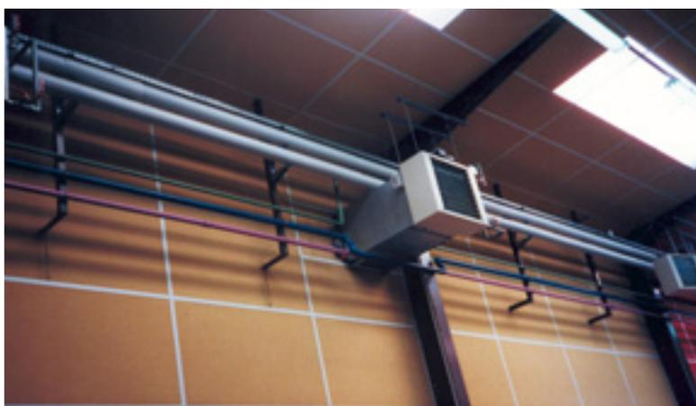
Photo 5.5. Système de chauffage d'un atelier.
