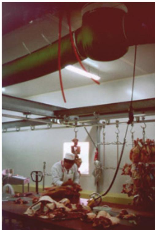
Photo 5.4. Gaines textiles dites « chaussettes » pour diffusion d'air à basse vitesse.
