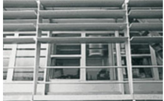
Photo 5.1. Dispositif de lames brise-soleil.
