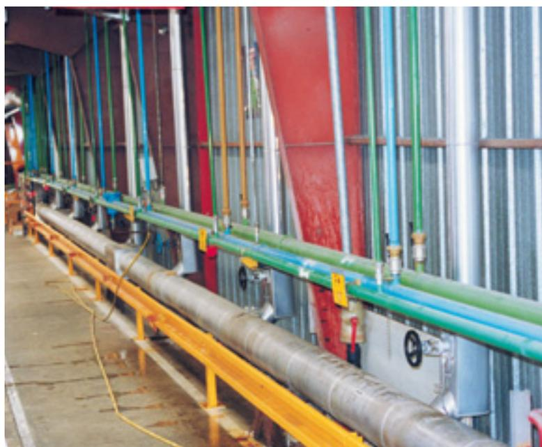
Photo 8.6. Fluides. Système de couleur pour le repérage des circuits des différents fluides.
