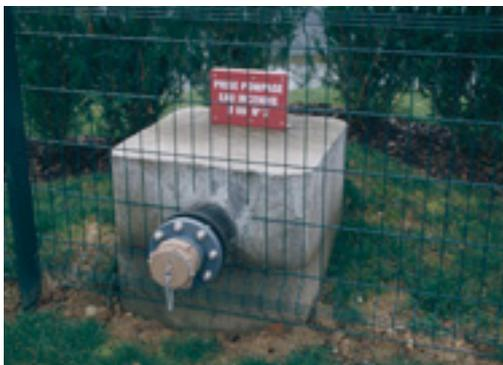
Photo 6.1.b. Prise d'eau à l'extérieur de l'enceinte grillagée.
