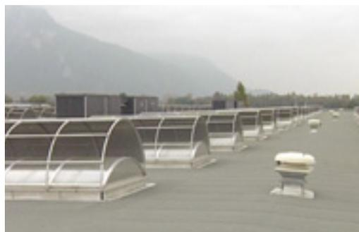
Photo 5.6. Exemple de protections solaires par l'extérieur sur lanterneaux en toiture, groupes de rafraîchissement d'air (caissons noirs au fond), extracteurs d'air (à droite).
