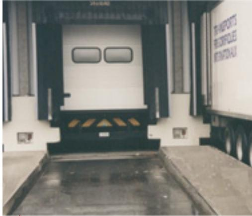
Photo 7.7. Quai aménagé avec guide-roues, rampe ajustable sur quai, butoirs assurant un espace de 500 mm, prises électriques pour groupe frigorifique avec passage pour le hayon en partie inférieure.
