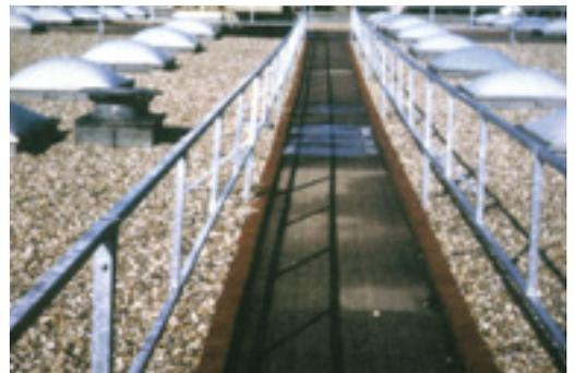
Photo 7.3. Passerelle permanente d'accès pour l'entretien d'installations sur toiture.
