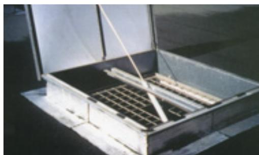
Photo 7.2. Lanterneau ouvrant équipé de grilles de protection en sous-face.
