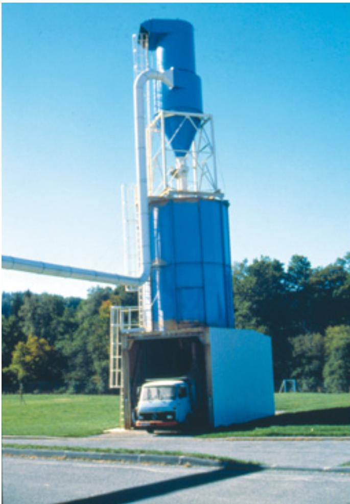
Photo 8.5. Accès et protection collective sur un silo.
