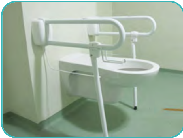
Barres de maintien escamotables avec béquille de renfort de part et d'autre de la cuvette WC
