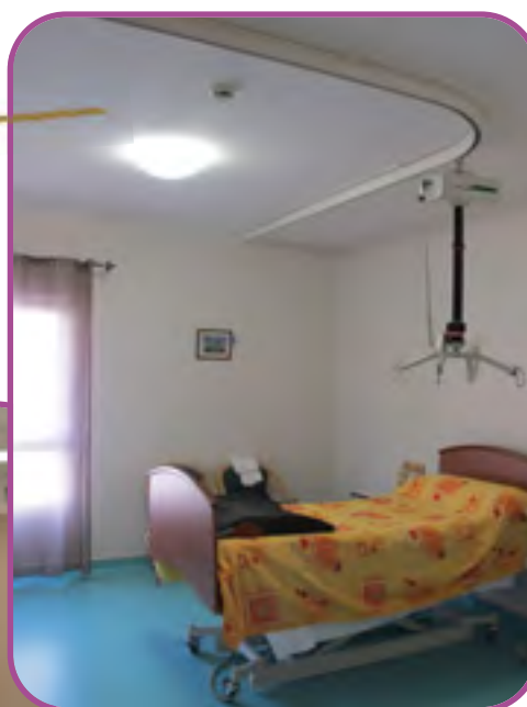
Chambre équipée d'un rail avec son moteur
