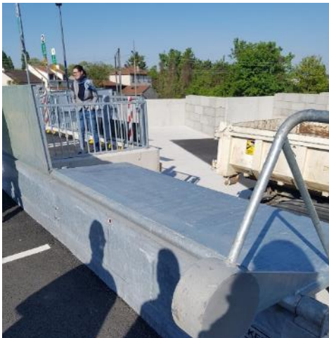
Barrière équipée d'une partie basse fixe (environ 70cm) et mobile (environ 60cm)
